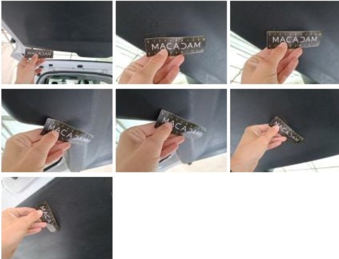
Joint de coffre, Déchirure, E - Remplacer
