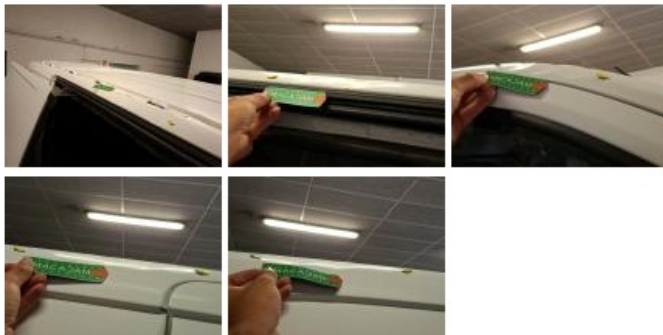
Joint de porte AR, Déchirure, E - Remplacer
